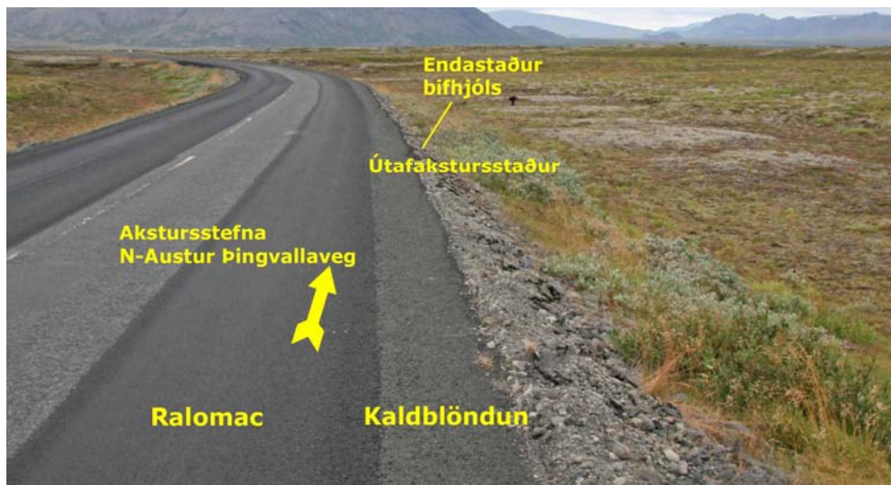
Mynd 1. Horft N-Austur Þingvallaveg. Viðgerð stóð yfir á veginum. Akreinaskil og vegbrún voru óljós.
