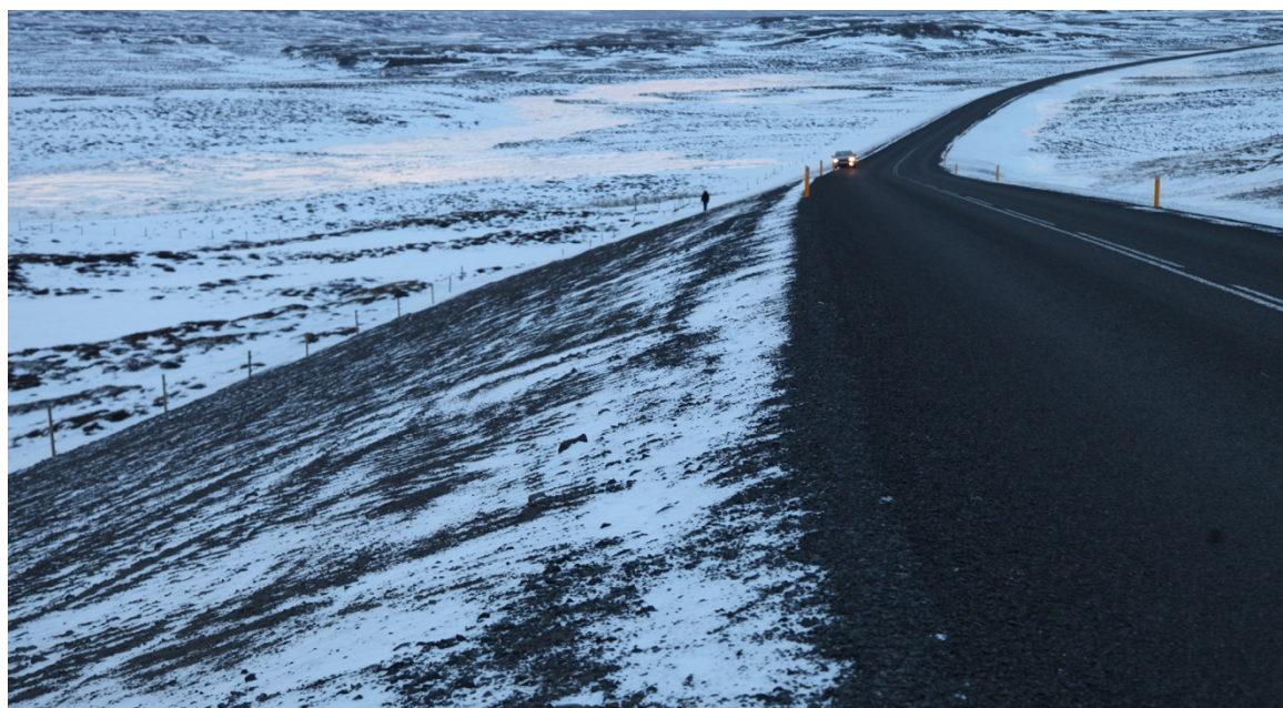
Mynd 1: Mynd fengin frá lögreglu tekin í suðurátt nokkrum dögum eftir slysið. Sjá má brattan fláa frá vegöxl og hæðarmun þar sem bifreiðin fór út af.
